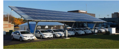
Şekil 7: PV destekli hibrit şarj istasyonu örneği [6]
